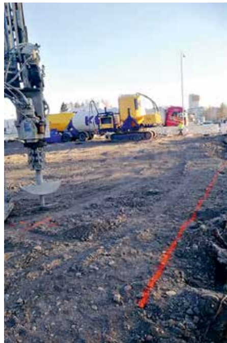
Stabilointikoneissa on GPS. Järjestelmä auttaa koneen kuljettajaa hahmottamaan koko kentän tarkemmin ja tehostaa stabilointia aiempaan käsimittaustyöskentelyyn verrattuna. Väriviivat varoittavat alueen johtolinjoista.
