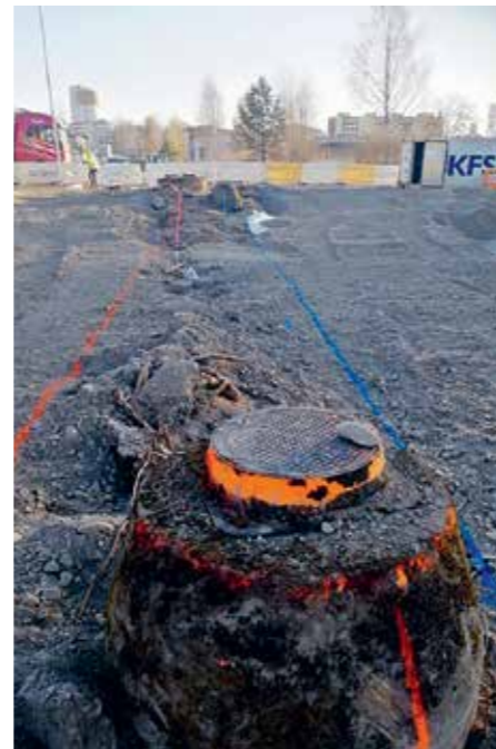
Stabilointikoneissa on GPS. Järjestelmä auttaa koneen kuljettajaa hahmottamaan koko kentän tarkemmin ja tehostaa stabilointia aiempaan käsimittaustyöskentelyyn verrattuna. Väriviivat varoittavat alueen johtolinjoista.
