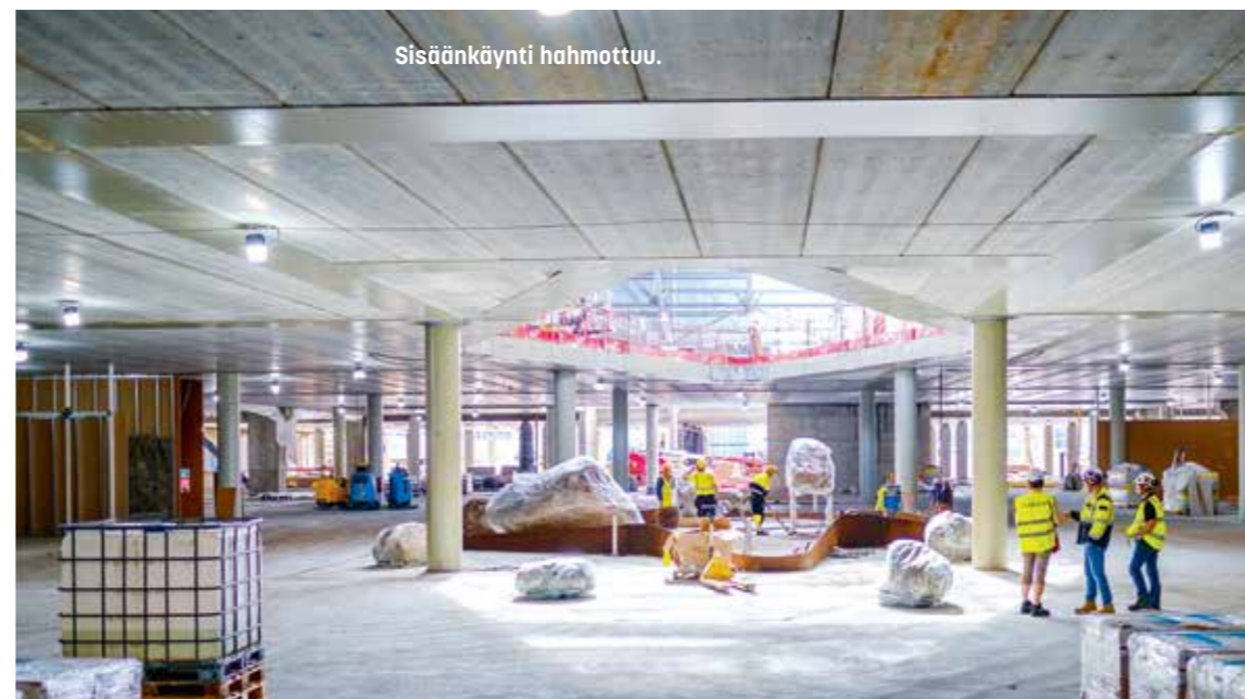
Uudessa pysäköintihalli P2:ssa on tilaa 1800 autolle. Kierreramppien valut on tehty SR-sementillä.
