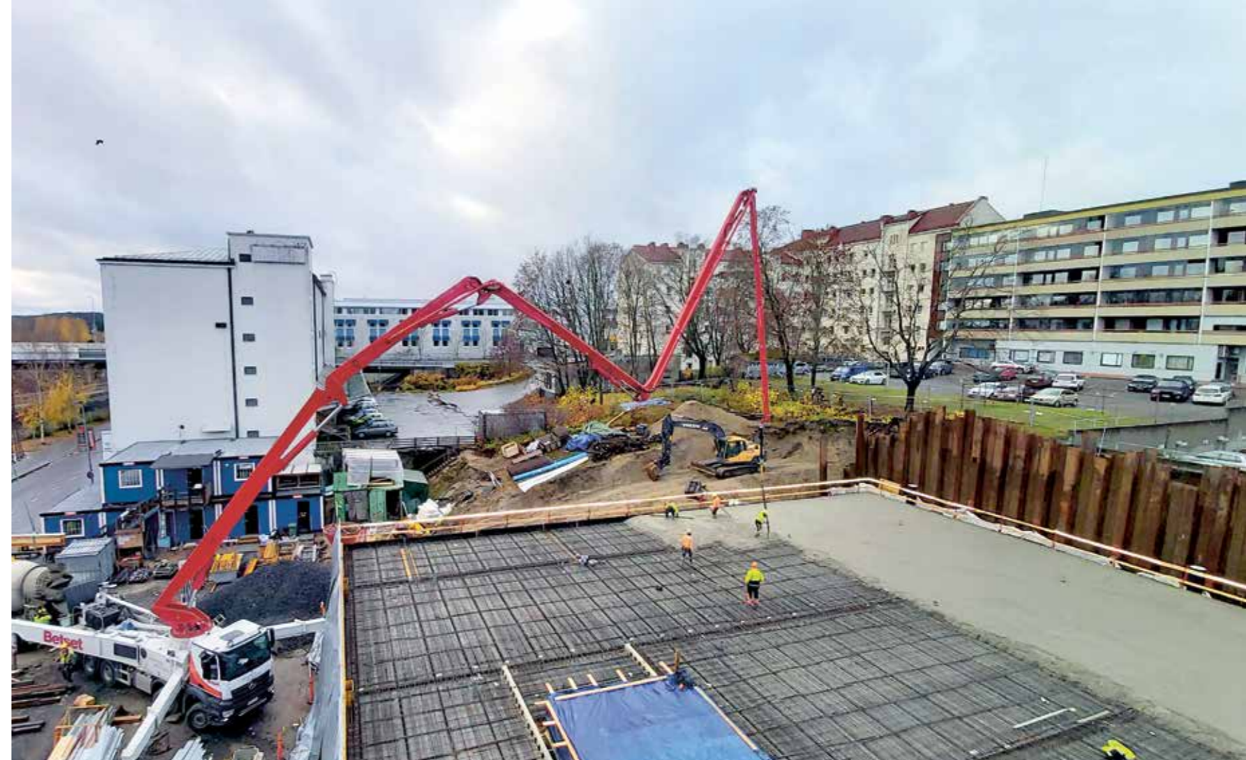
Mikkelissä vanhojen viljasiilojen paikalle rakennetaan tornitalo. Betset-yhtiöiden työmaalla tehdään parkkihallin valuja lokakuussa 2020.
