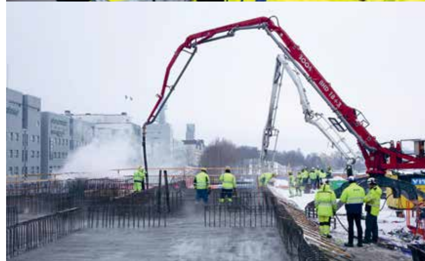
Triplan työmaalla tehtiin useita valuja samanaikaisesti.
